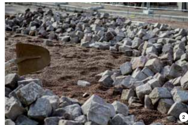
2. I cubetti scarificati dalla precedente pavimentazione, puliti e burattati, pronti per essere posati per la nuova pavimentazione.
