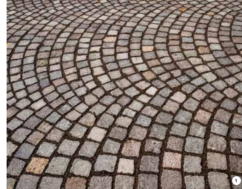
1. Dettaglio della nuova pavimentazione in cubetti di porfido, con le fughe riempite da frantumato di porfido legato da MAPESTONE JOINT, resina poliuretanicamente esente da solventi.
