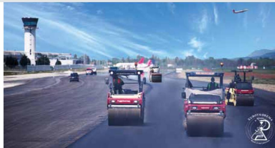
**A SINISTRA.** Fase di stesa e compattazione dello strato di usura modificata con MAPEI E-SBC 2 delle taxiways.
