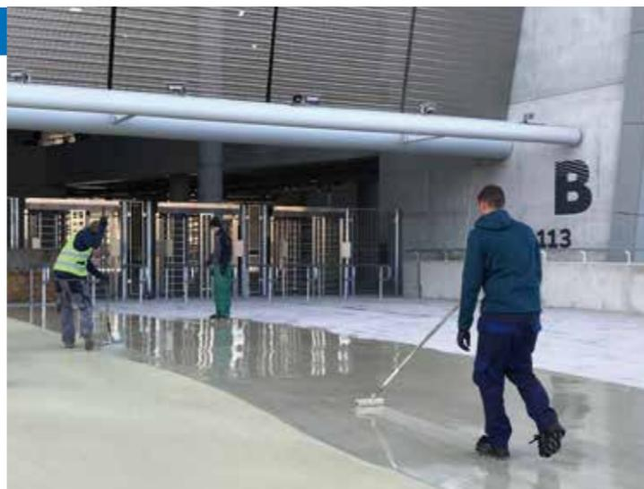
**A SINISTRA.** Per impermeabilizzare le strutture in sottoterraneo soggette a pressione di acqua del terreno e per le superfici a piano terra sottoposte a umidità del suolo, sono state usate le emulsioni PLASTIMUL 2K SUPER e PLASTIMUL 1K SUPER PLUS, in grado di assicurare un'ottima resa e un'eccellente adesione ai supporti.
