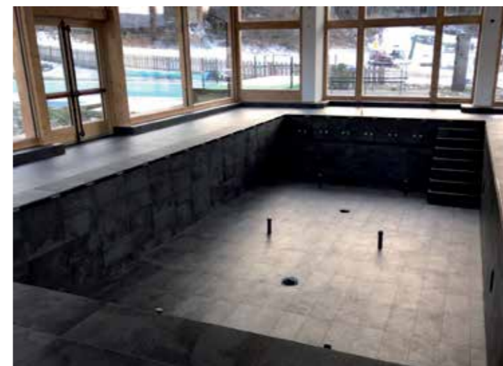
La posa delle piastrelle nella vasca e sui bordi è stata effettuata con ELASTORAPID; per la stuccatura è stato scelto KERAPOXY CQ.
