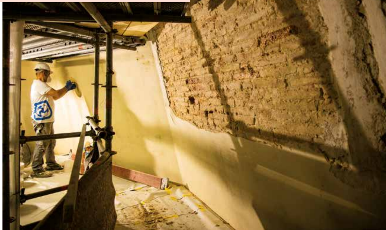
Consolidamento e riadesione degli intonaci distaccati dai supporti mediante iniezioni con MAPE-ANTIQUE F21.
