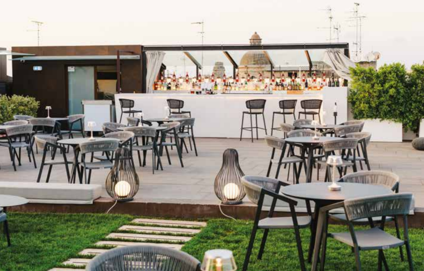
La terrazza dell'edificio è stata trasformata in un giardino pensile. La superficie cementizia è stata impermeabilizzata con la membrana bicomponente a base di poliurea pura PURTOP 1000.
