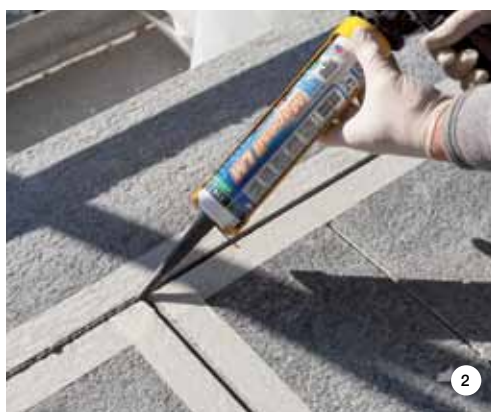
FOTO 1. L'impermeabilizzazione delle fondazioni è stata realizzata con il telo bentonitico MAPEPROOF LW. FOTO 2. Per sigillare i giunti su terrazzi e ballatoi è stato usato MAPESIL LM.
