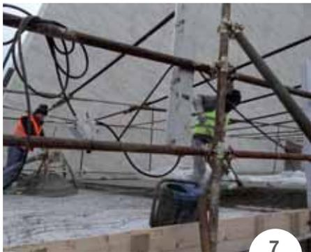
**FOTO 7.** Il nuovo sottofondo realizzato con TOPCEM PRONTO.
