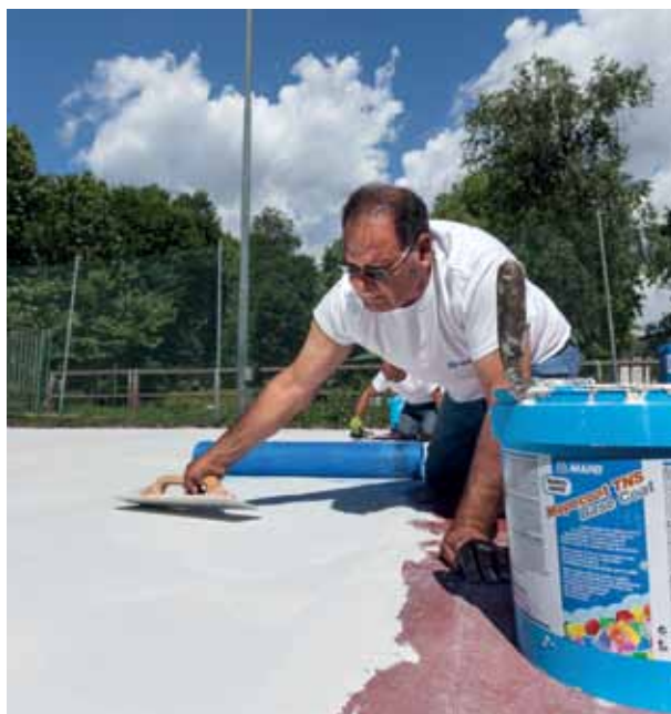
SOPRA. Le superfici del campo sono state trattate con il fondo riempitivo semi-elastico MAPECOAT TNS WHITE BASE COAT. Contestualmente è stata posata la rete in fibra di vetro MAPENET 150. IN BASSO. Una volta asciugato il fondo, è stato applicato il rivestimento colorato MAPECOAT FINISH 3.
