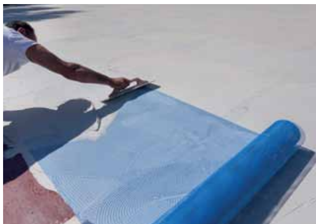
SOPRA. Le superfici del campo sono state trattate con il fondo riempitivo semi-elastico MAPECOAT TNS WHITE BASE COAT. Contestualmente è stata posata la rete in fibra di vetro MAPENET 150. IN BASSO. Una volta asciugato il fondo, è stato applicato il rivestimento colorato MAPECOAT FINISH 3.
