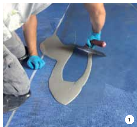
FOTO 1 e 2. Dopo la realizzazione del massetto è stato applicato PRIMER SN, con inglobata la rete MAPENET 150 poi spolverata a rifiuto di QUARZO 0,5.
