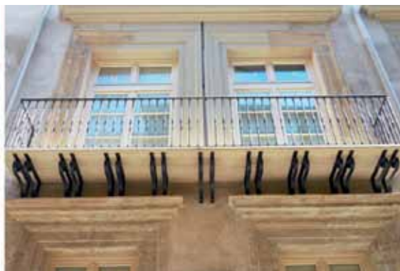
FOTO 1 e 2. Per incollare le modanature, i contorni delle finestre e i cornicioni è stato utilizzato MAPETHERM AR1.
