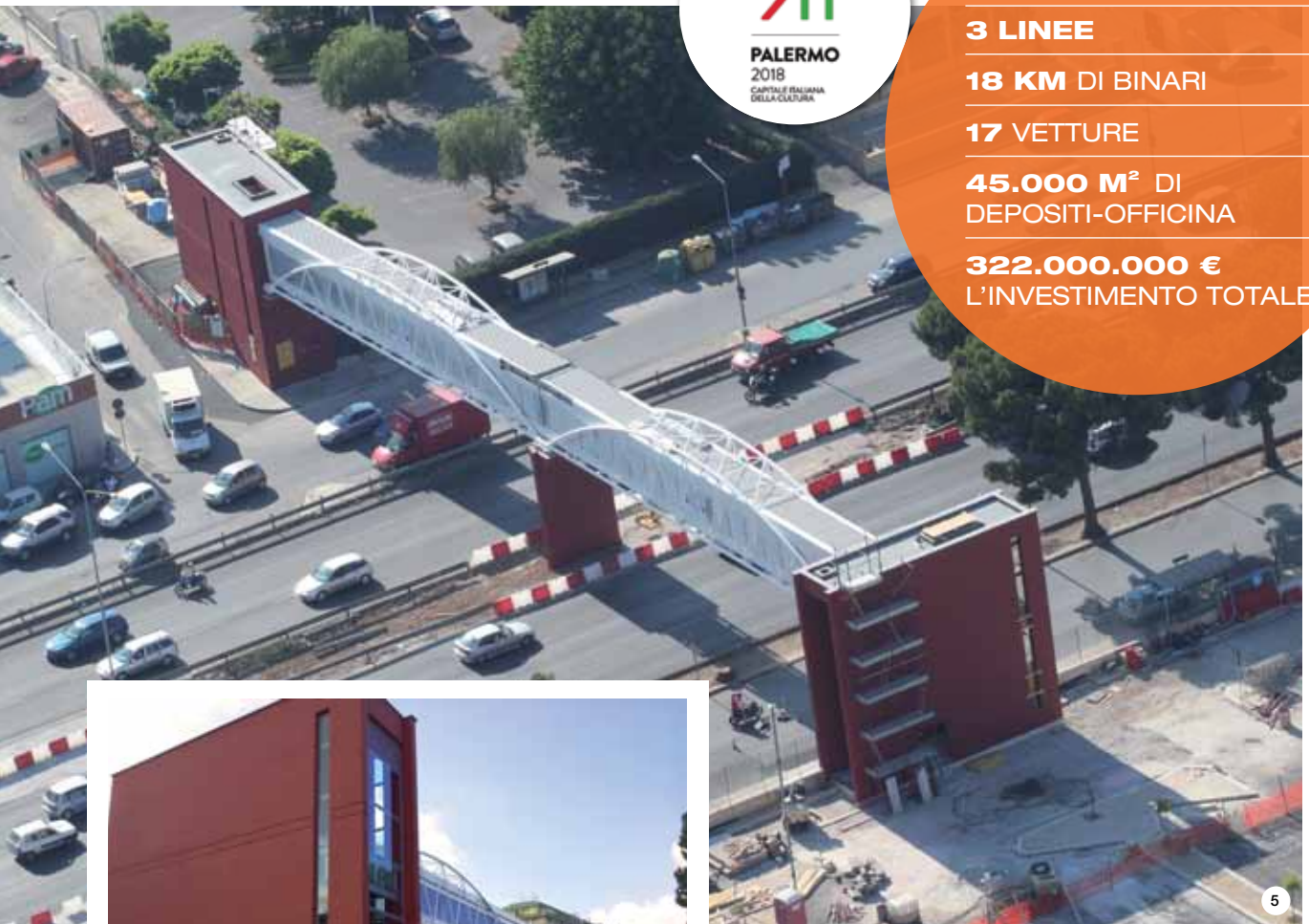
FOTO 4 e 5. Sulle strutture in calcestruzzo dei sovrappassi pedonali è stata applicata la vernice protettiva ELASTOCOLOR PITTURA.
