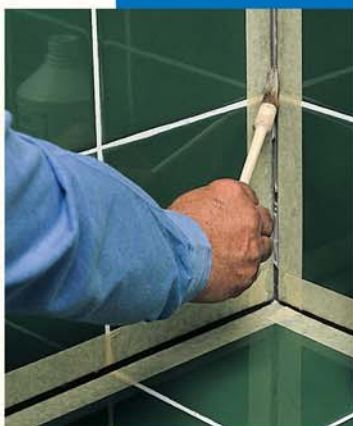
Application of Primer FD.
