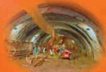
TUNNEL DE CEUTA
